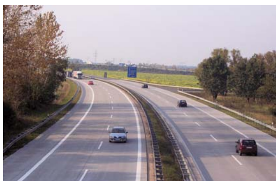
Übergang auf RQ 29,5 am Bauende
