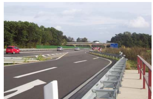
Bauanfang an der AS Leipzig - Messegelände
