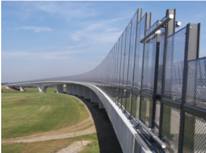
Abbildung 1: Elbebrücke bei Mühlberg mit Kollisionsschutz wand
