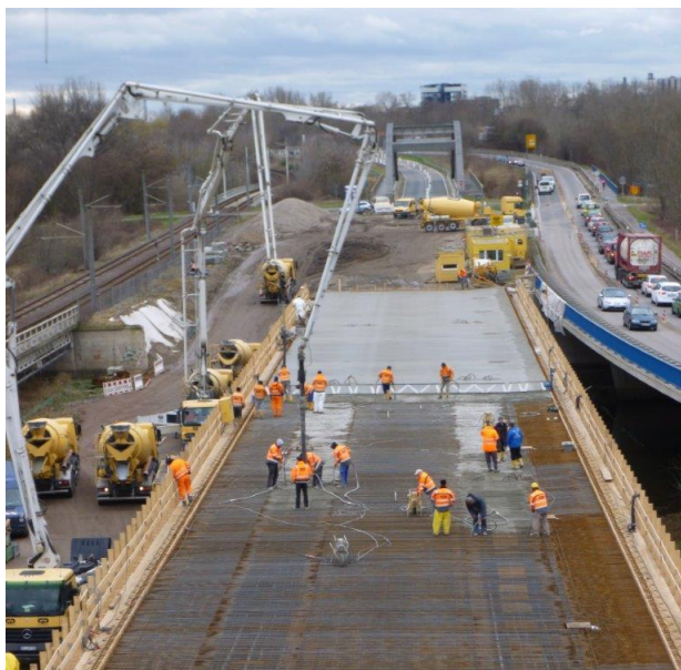
Betonage des Überbaus
